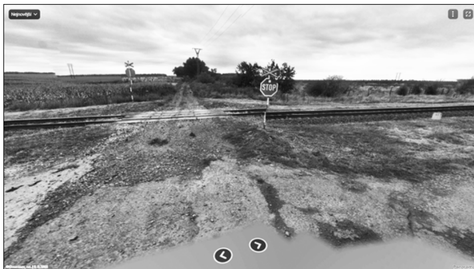
Foto zrušeného přejezdu – stav ke dni 16. 9. 2016
